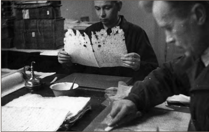
Keskarhiivi köitja-fotograaf Helmut Rammo (vasakul) ja tema abiline Voldemar Kippasto käsikirju restaureerimas, 1940. Fotolt võib leida tänapäevalgi kasutusel olevaid materjale ja töövahendeid: jaapani paber, jahukliister, pulverisaator, pintsel, voolimisluu. RA, EAA.661.1.806, l. 9
