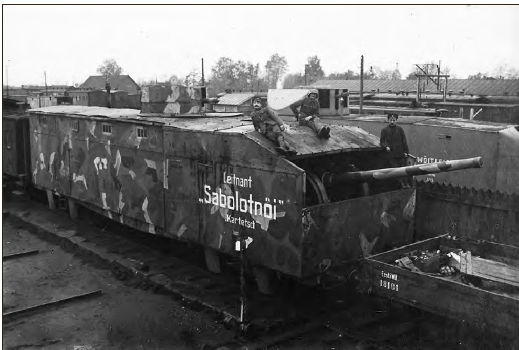
1919. aasta augustis Tallinna Sadamatehases ehitatud suurtükivagun Leitnant Sabolotnoi Kartetsch oli oma 120 mm Inglise kahuriga üks võimsamaid Vabadussõjas. Valga oktoobris 1919. Foto autor teadmata. EFA.257.A.287.233
